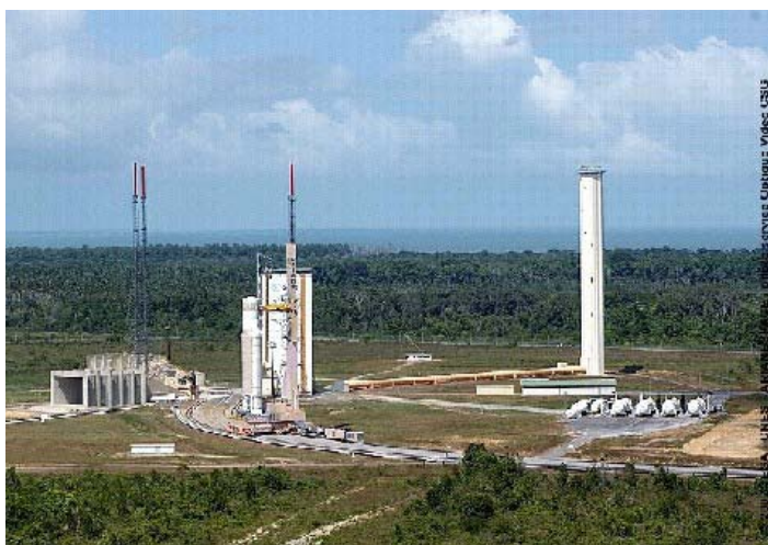
Kourou : transfert du Bâtiment d'Assemblage Final (BAF) en zone de lancement pour la Répétition de la Séquence de Lancement (RSL). © ESA/ARIANESPACE/Service optique CSG
