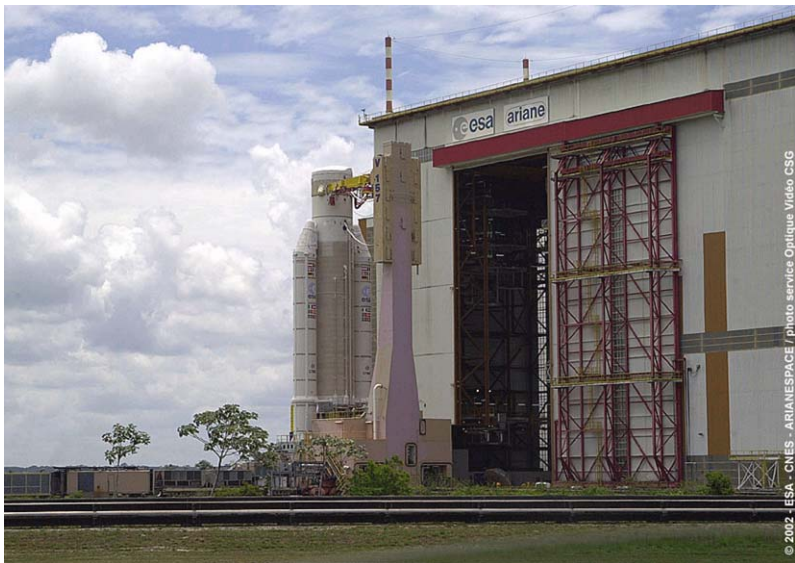
Kourou : transfert du lanceur du Bâtiment d'intégration Lanceur (BIL) au Bâtiment d'Assemblage Final, sans sa coiffe. © ESA/ARIANESPACE/Service optique CSG
